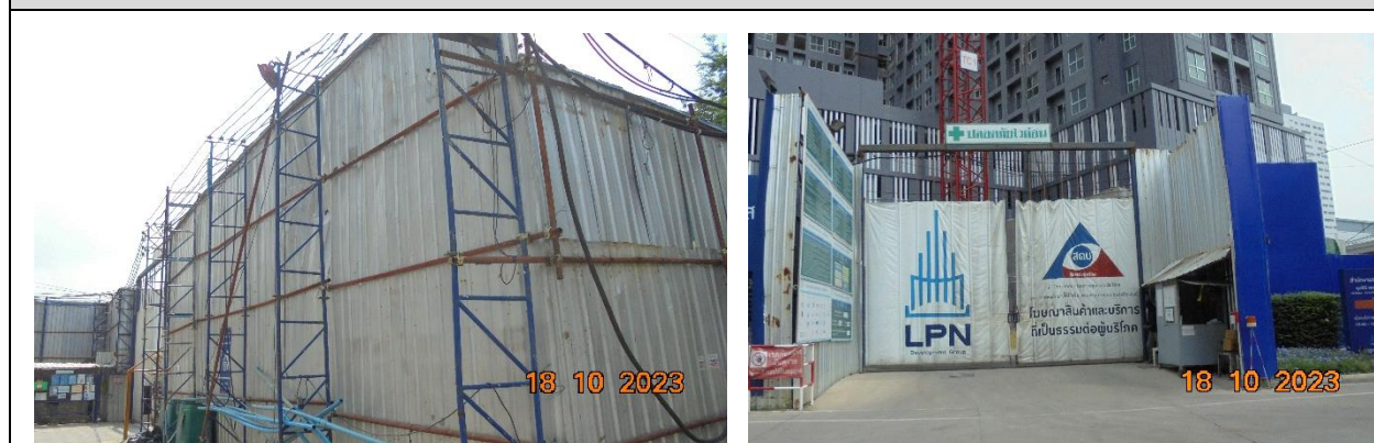
ภาพที่ ก-2 รั้ว Metal Sheet สูง 6 เมตร และประตูทางเข้า-ออก พื้นที่ก่อสร้าง
